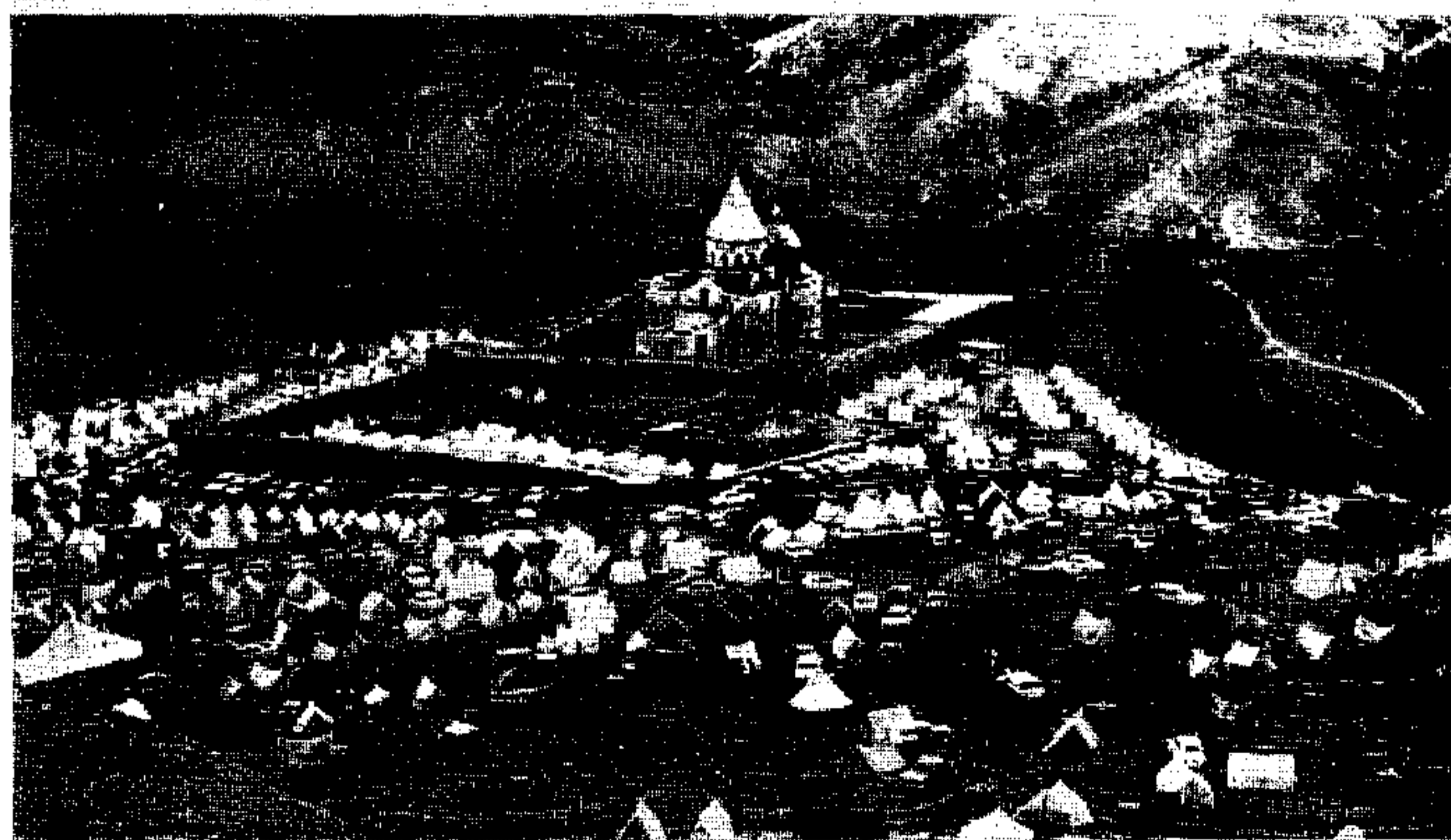
یکی از قدیمیترین کلیساها که مربوط به ارامنه ایران است، ۸۰۰ سال قبل بر روی کوههای مرتفع طراف ماکو ساخته شده و فرم و محل ساختمان آن از هر نظر مورد تحسین و اعجاب است . بن بنای قدیمی مذهبی که با دقت مراقبت میشود در اکثر ایام سال مخصوصاً در تابستانها مورد بازدید سیاری از مردم است و ارامنه برای انجام فرائض مذهبی با اشتیاق با آنجا میروند.
